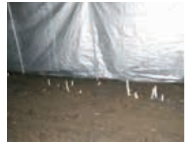
トンネル内の様子
