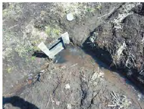
溝きり施工し排水溝につなげることで、停滞水を効率良く除去できる。
